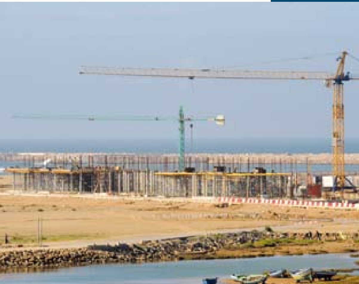
• Vue d'ensemble des travaux - Front fluvial
