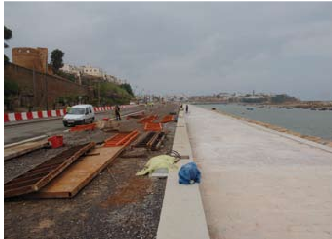
• Travaux de réalisation des Quais de Rabat
