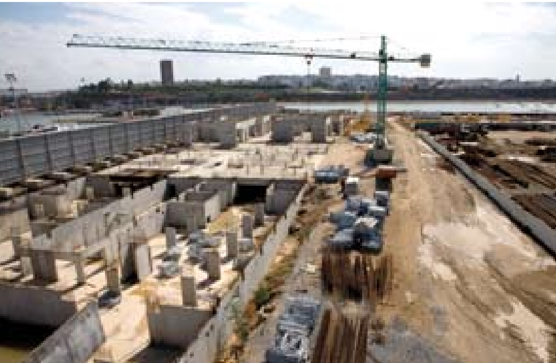
• Vue d'ensemble des travaux du front marina
