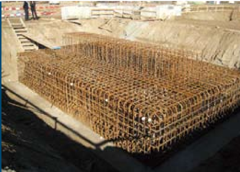
• Ferrailage de la semelle de pile
