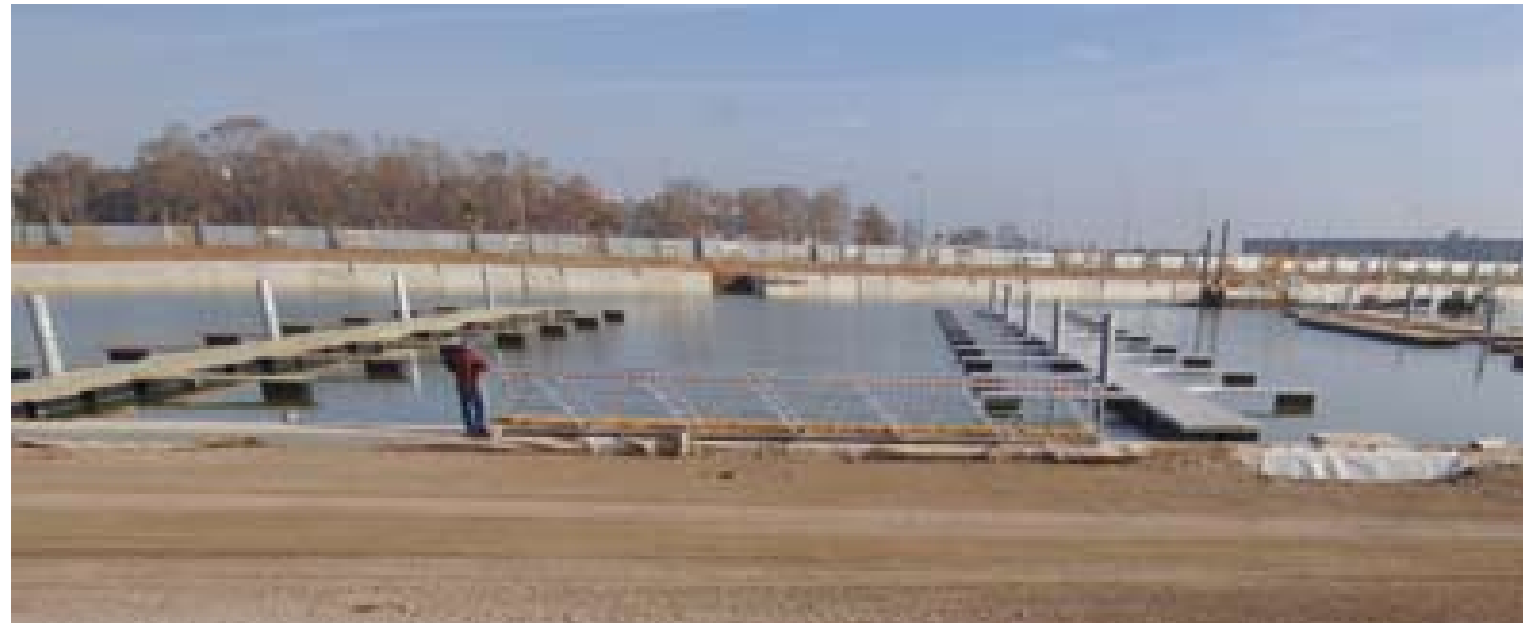
• Installation des équipements
