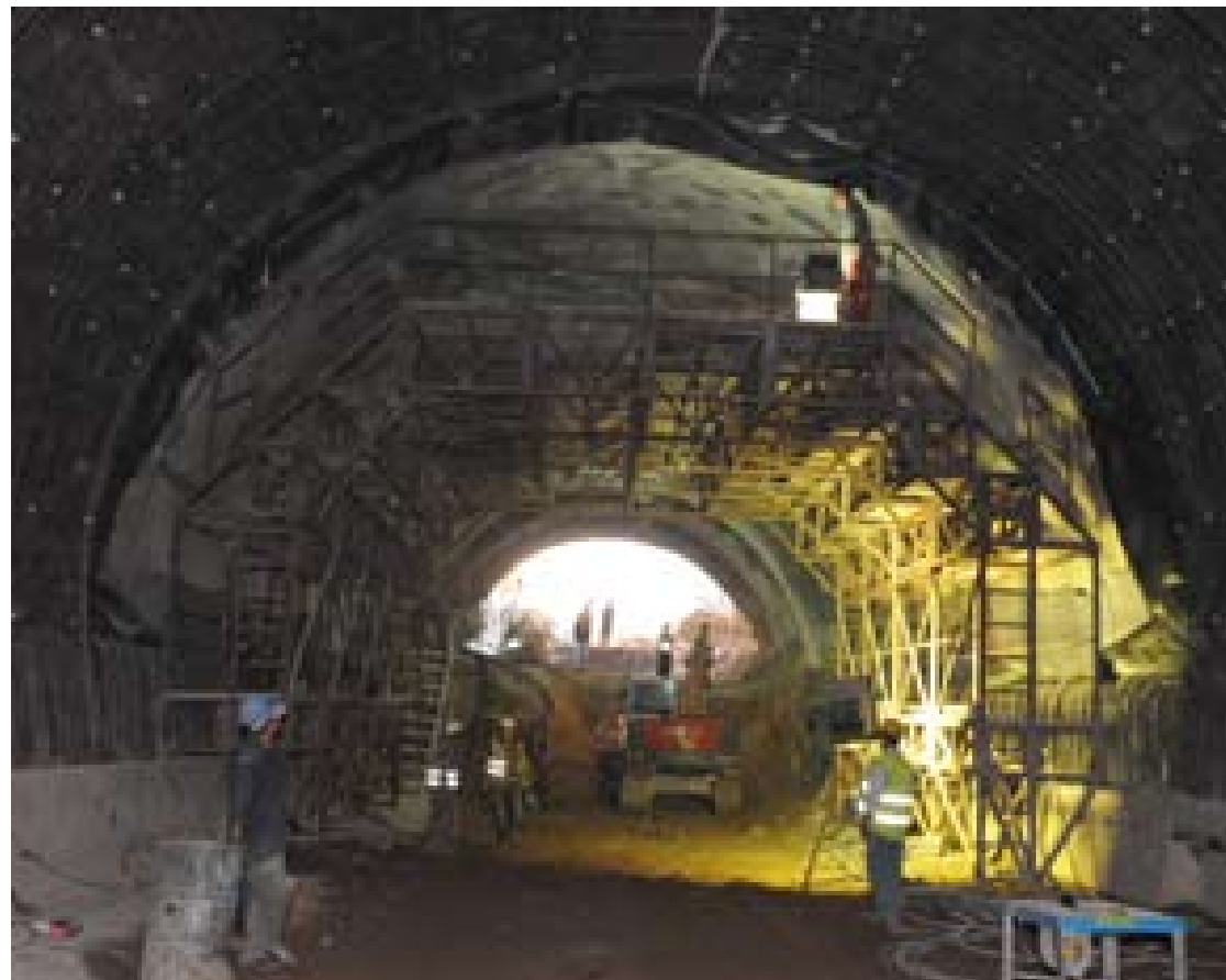
• Mise en place de ferrailage et étanchéité
