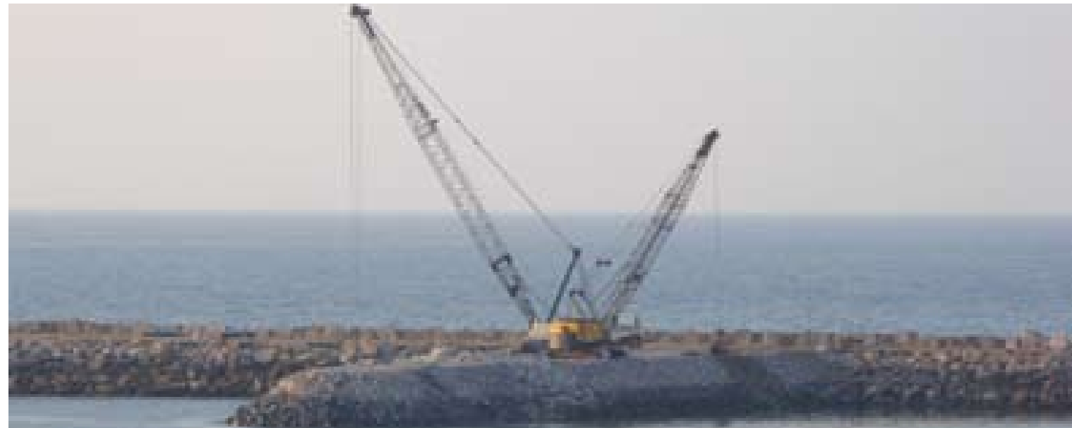
• Travaux d'installation de la brise-lame
