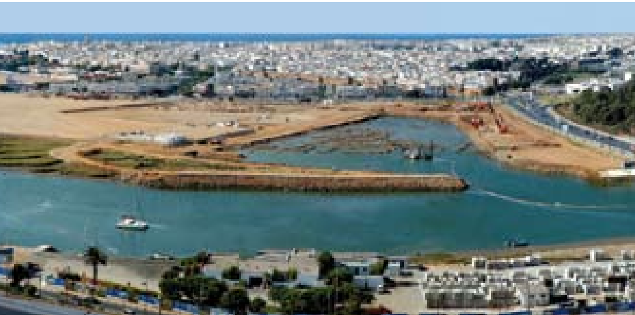
• Travaux de réalisation du bassin de la Bouregreg Marina
