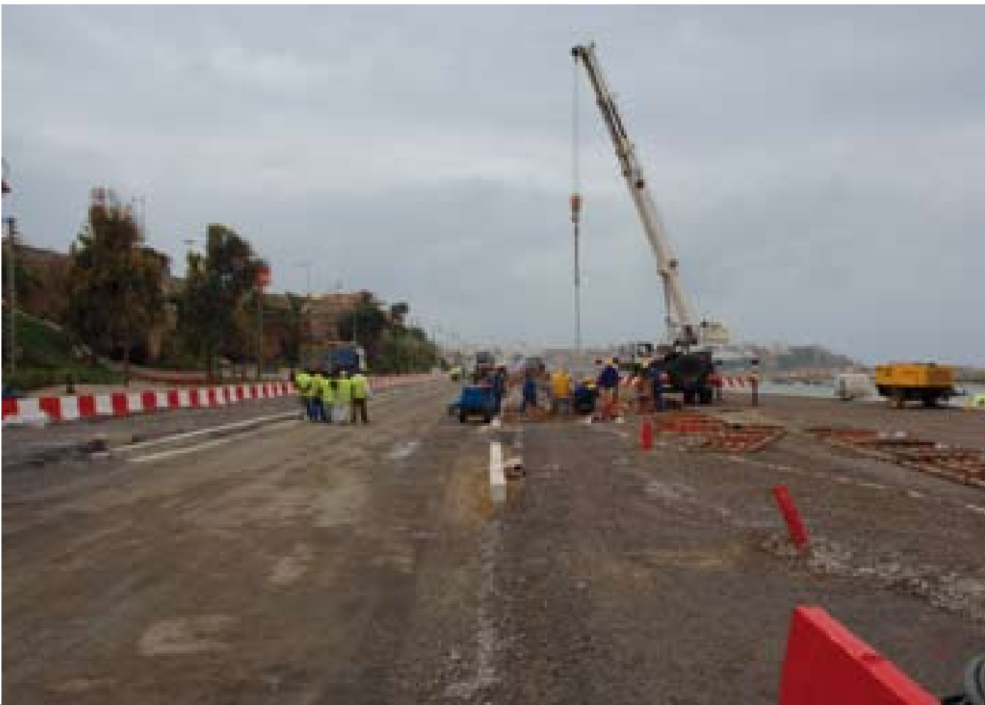
• Travaux de réalisation des Quais de Rabat
