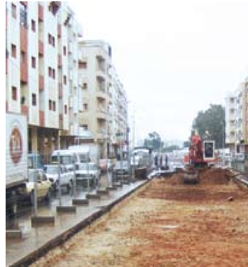
• Travaux de terrassement - Av. Mohammed V, Salé
