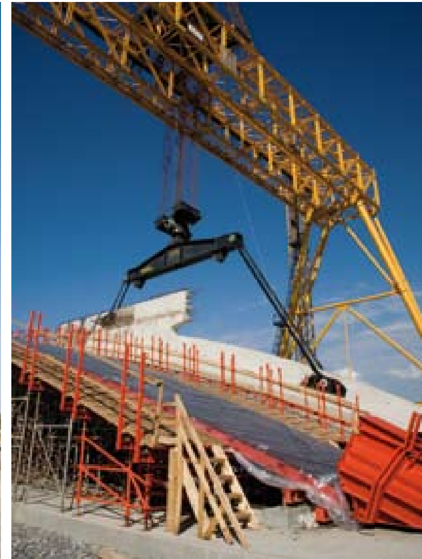
• Manutention pour stockage de la palme centrale
