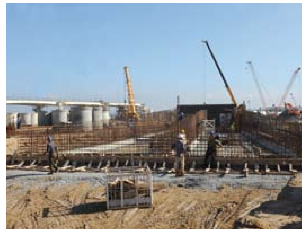
• Travaux de la culée creuse de la rampe du Tramway
