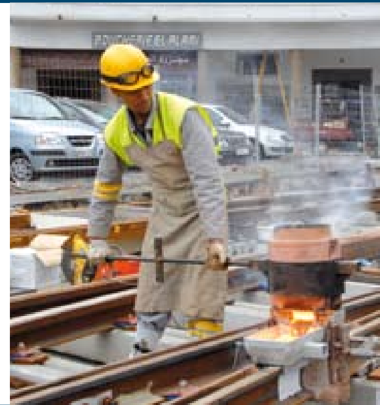
• Travaux de soudure - Place Al Joulane, Rabat
