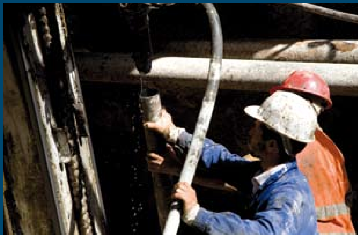
• Opération de perforation - Mise en place des tubes
