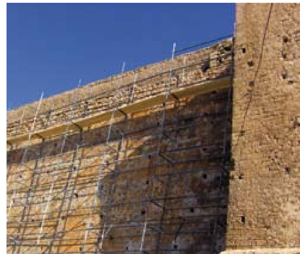
• Restauration des remparts de la Qasbah des Oudayas
