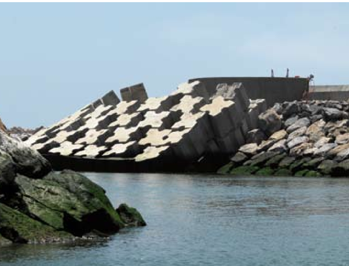
• Mise en place des enrochement
