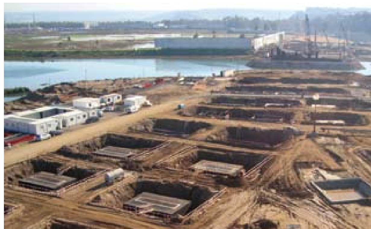
• L'achèvement des semelles du Viaduc de Salé
