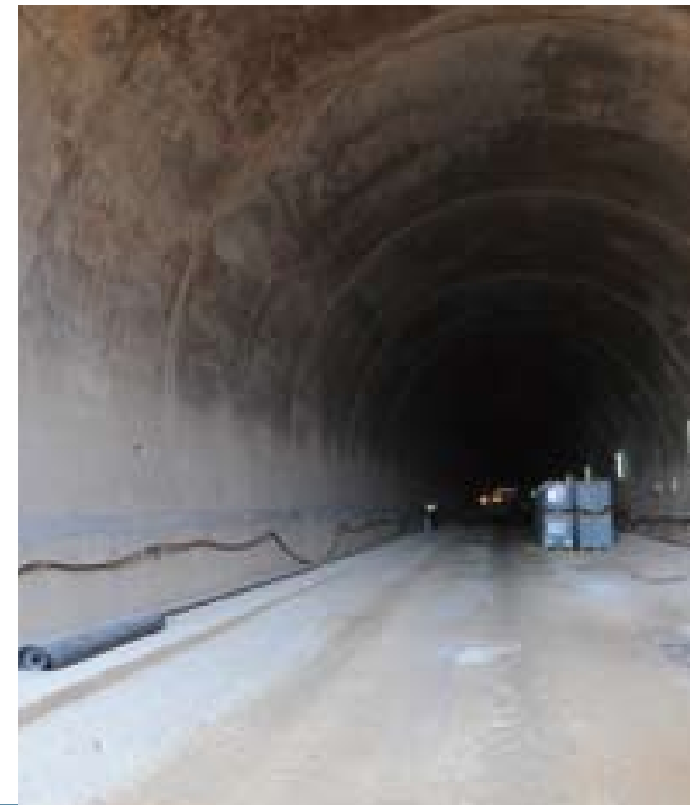
• Revêtement définitif du tunnel
