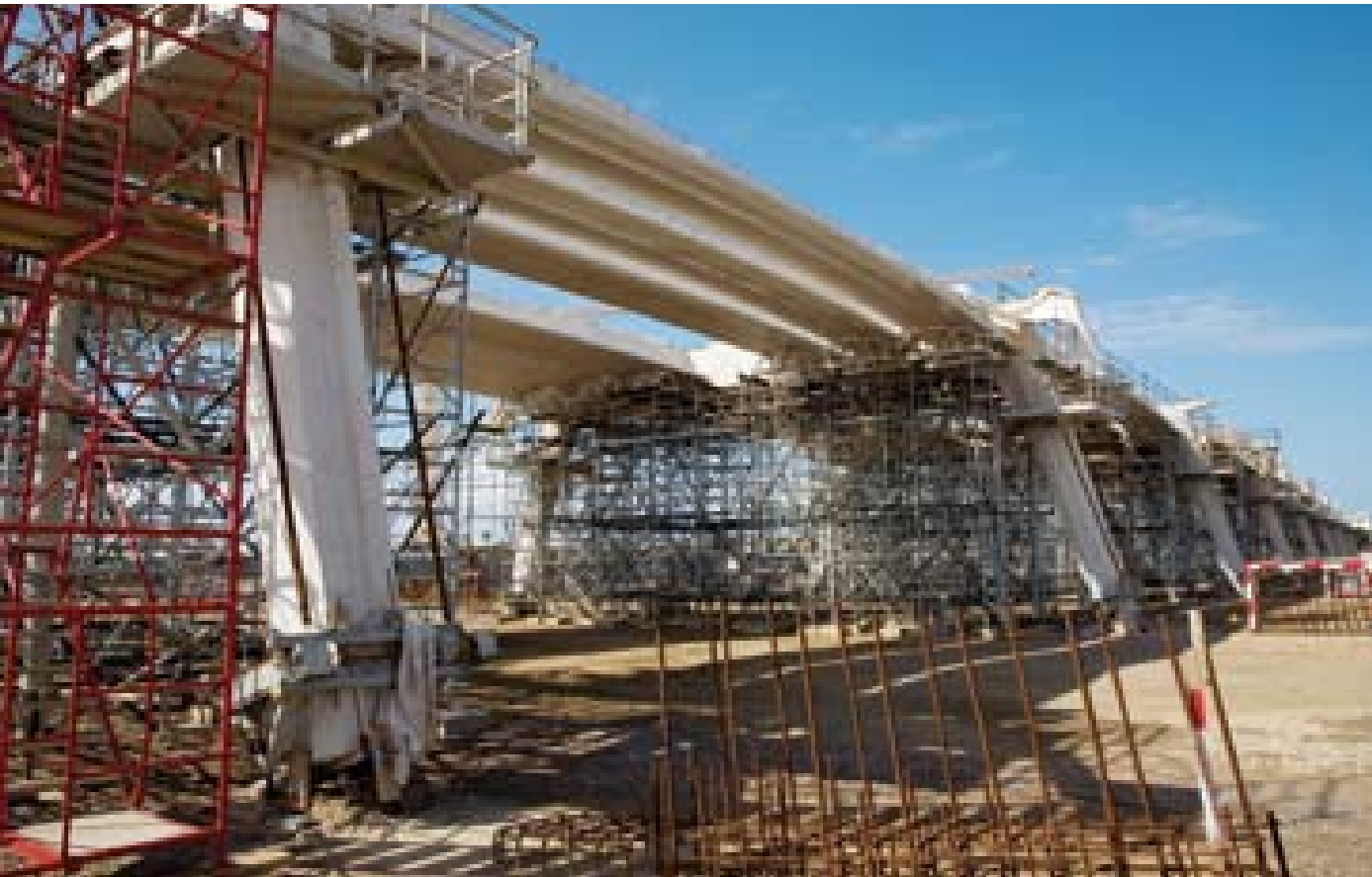
• Vue générale du Viaduc de Salé
