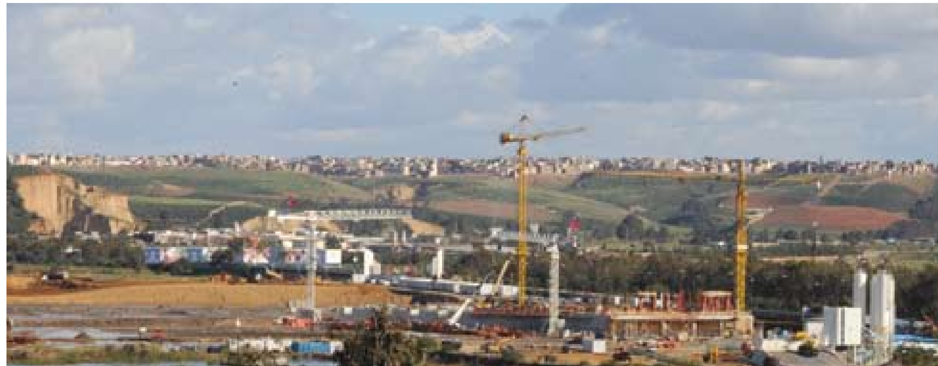
• Vue d'ensemble des travaux - Amwaj
