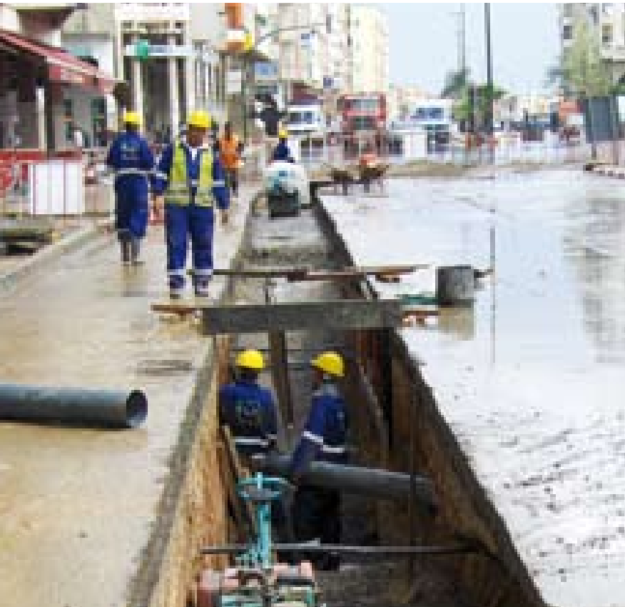
• Déviation des réseaux - Av. Mohammed V, Salé
