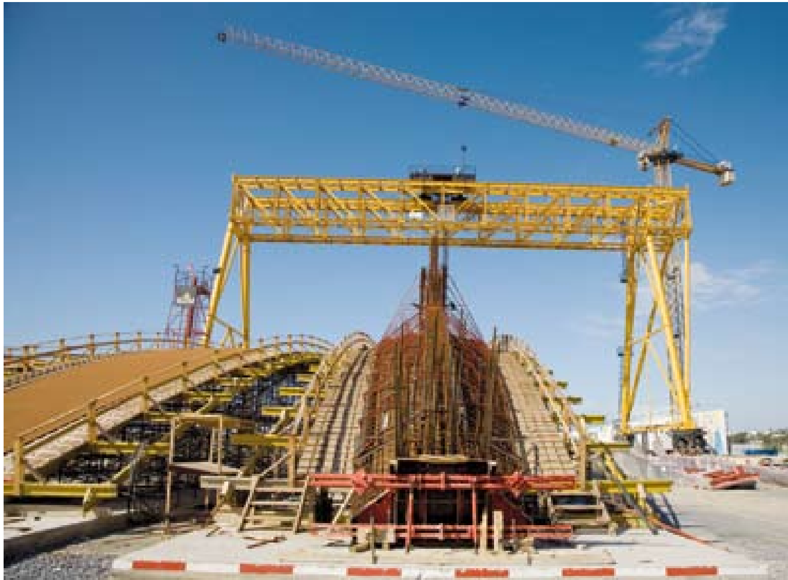
• Le gabarit de ferrailage des palmes
