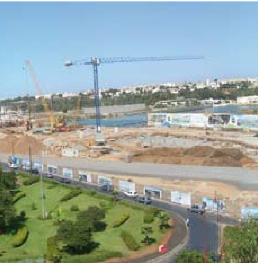
• Vue d'ensemble des travaux de la culée creuse côté Rabat
