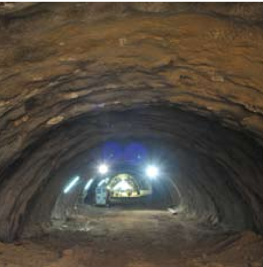
• Soutènement provisoire de la demi-section supérieure
