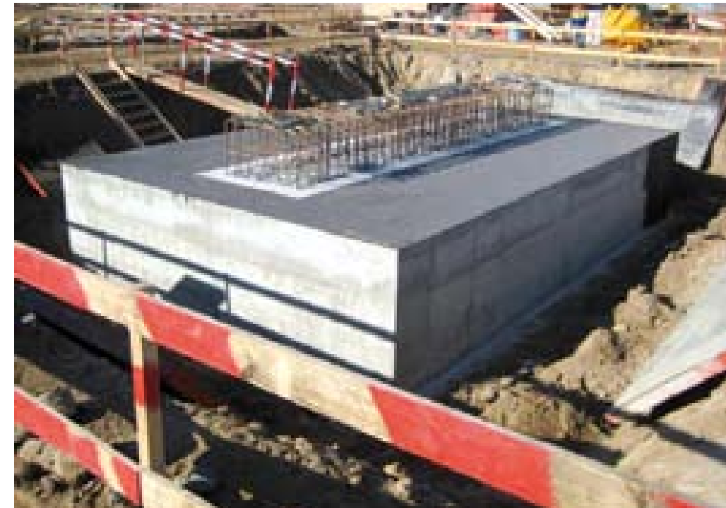
• La semelle après décoffrage
