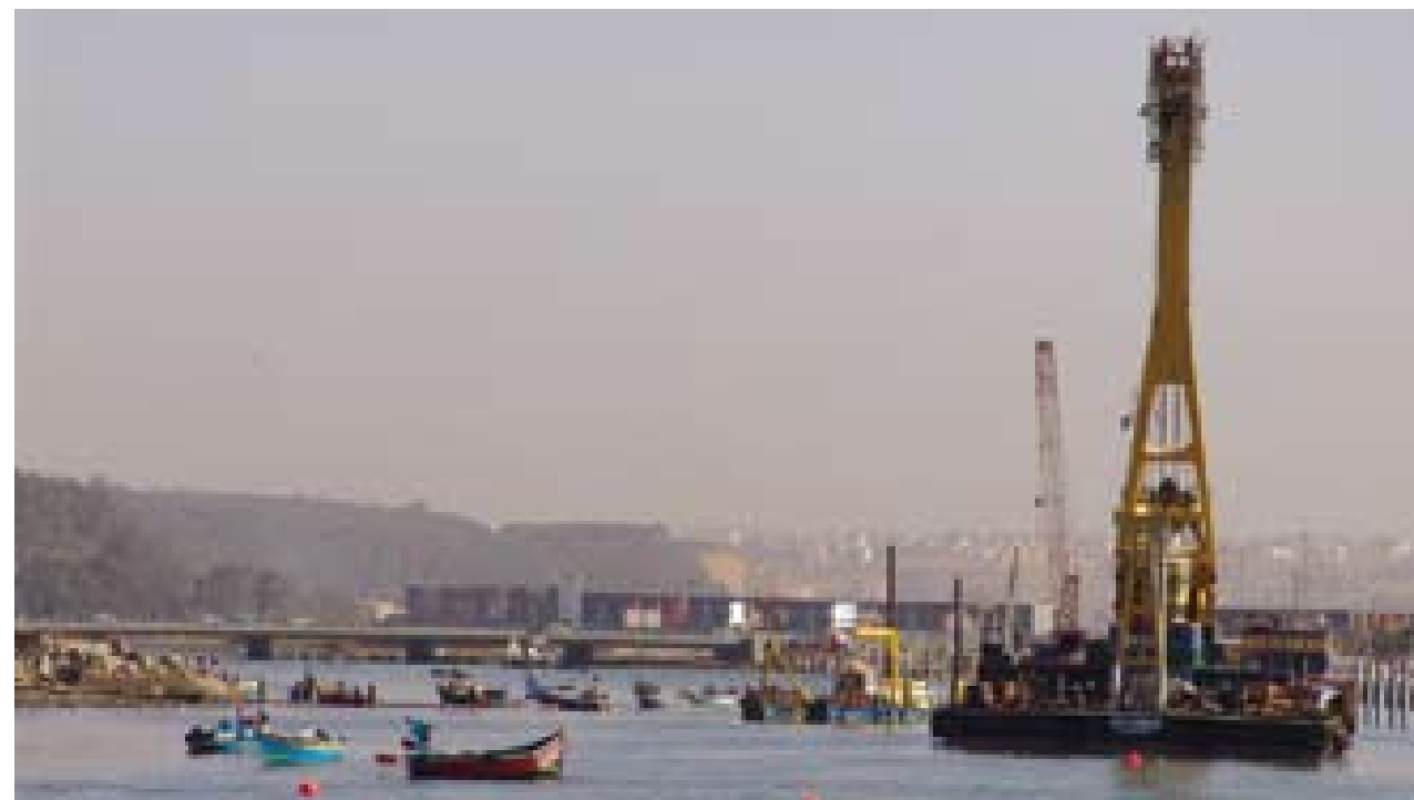
• Travaux de dragage
