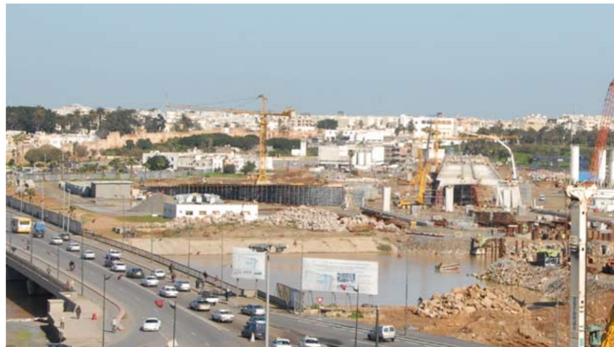
Chantier du pont Moulay El Hassan. Vue sur le tablier tramway et sur les deux tabliers routiers. Décembre 2009
