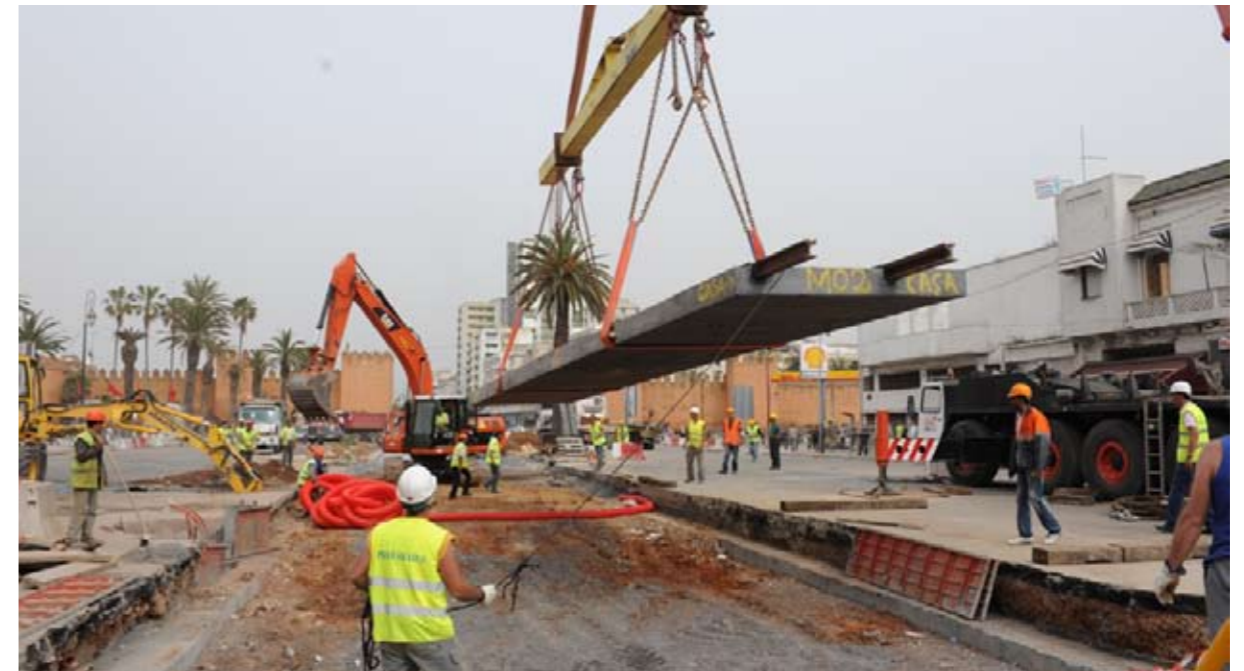
Pose d'éléments préfabriqués à Bab Al Had, Rabat. 23 Mars 2010.
