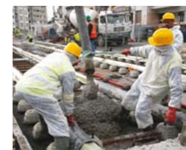
Dalle de calage du BC5 sur laquelle sont fixés les rails. Avenue Mohammed V, Salé.
