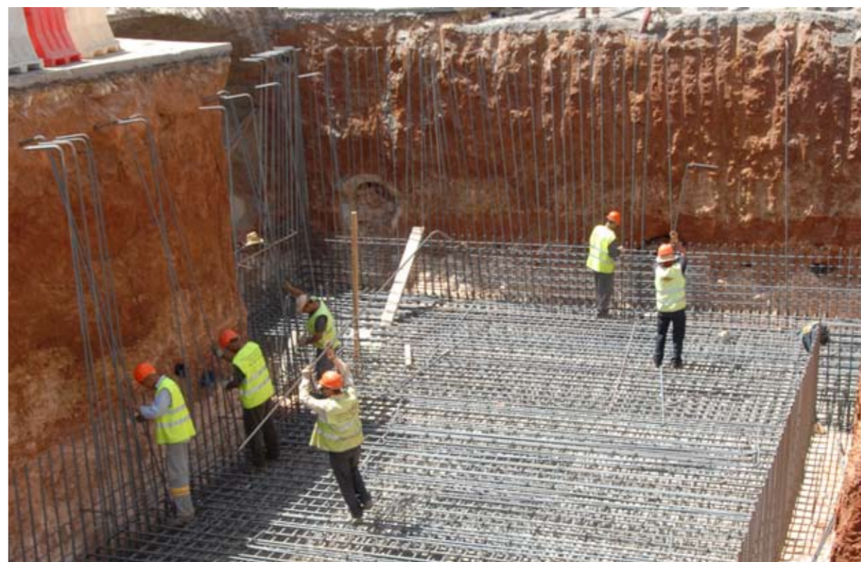
Réalisation de la sous-station enterrée. Avenue de France, Rabat. Septembre 2009
