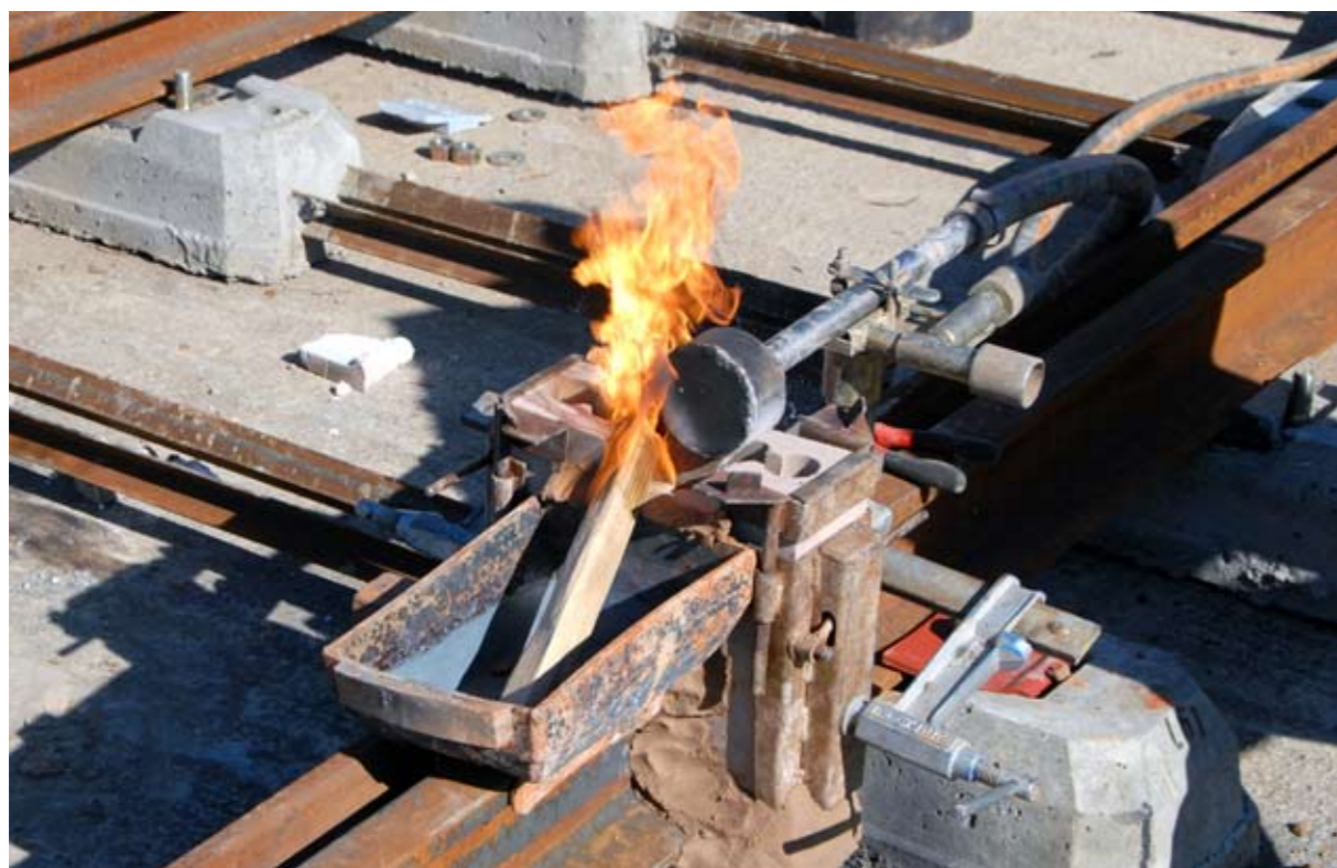
Première soudure le 16 octobre 2008 sur l'avenue Al Alaouyne à Rabat.
