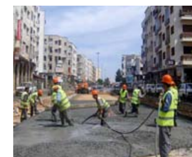
Coulage du béton de fondation Avenue Mohammed V, Salé.
