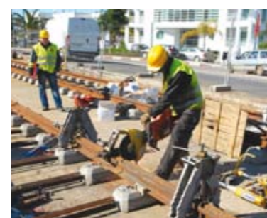
Pose et soudure de rail Avenue Ibn Khaldoun, Rabat.
