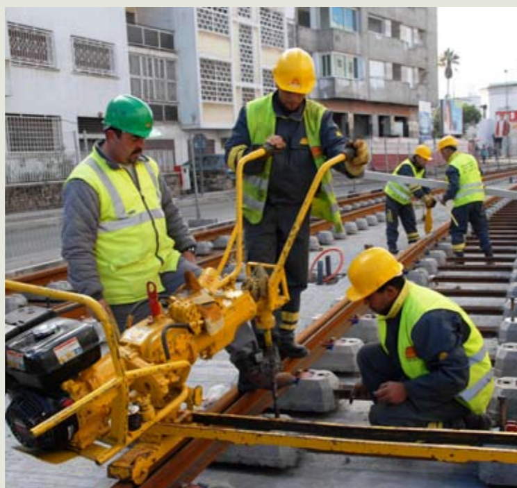
Un chantier pourvoyeur d'emplois et de formation pour de nouveaux métiers
