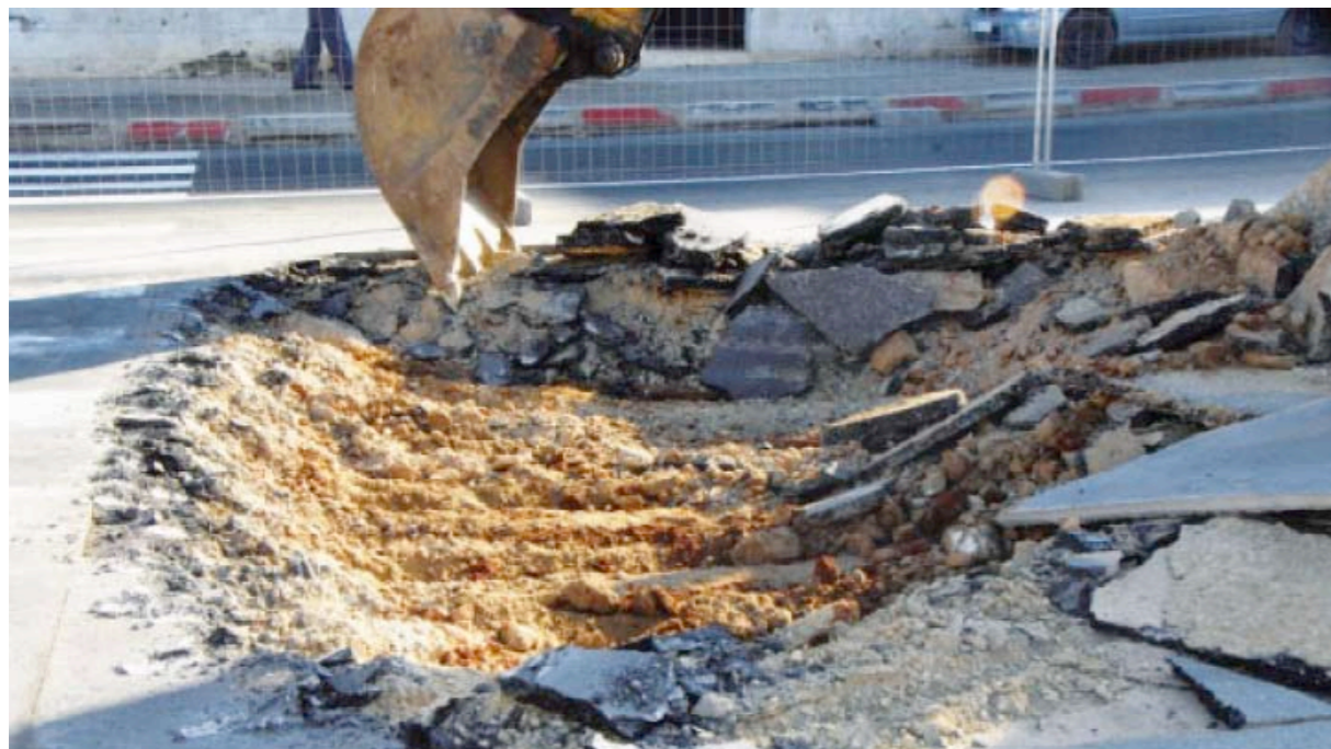
Lancement des travaux le 23 décembre 2007 à Salé.
