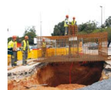
Terrassement de la plateforme Avenue des Nations Unies, Rabat.
