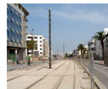
Pose de la ligne aérienne de contact. Avenue Al Alaouine, Rabat.
