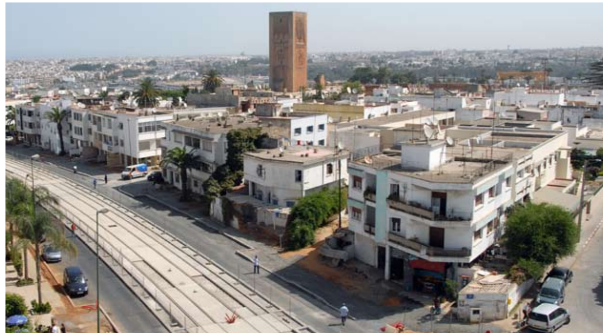
Aménagement urbain en cours. Avenue Al Alaouyine à Rabat. Juillet 2009.
