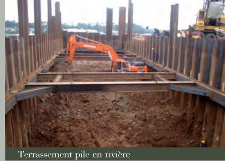
Terrassement pile en rivière
