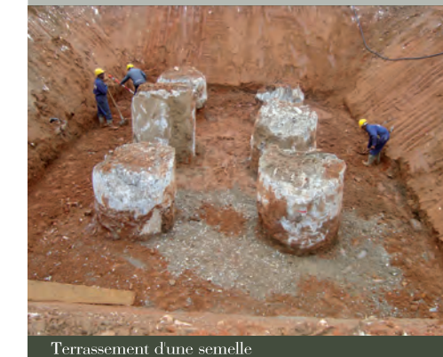
Terrassement d'une semelle
