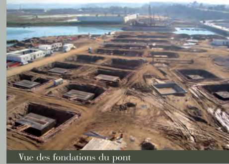
Vue des fondations du pont
