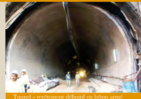
Tunnel - revêtement définitif en béton armé
