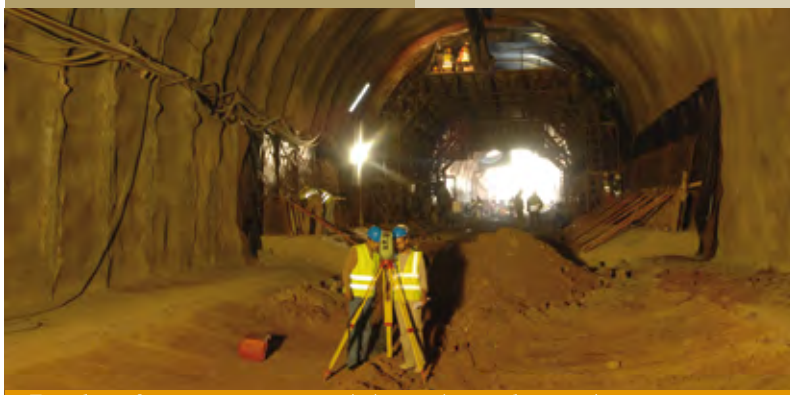
Tunnel côté Océan - soutènement provisoire par cintres et béton projeté
