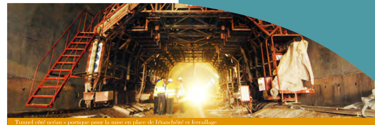
Tunnel côté océan - portique pour la mise en place de l'étanchéité et ferrailage
