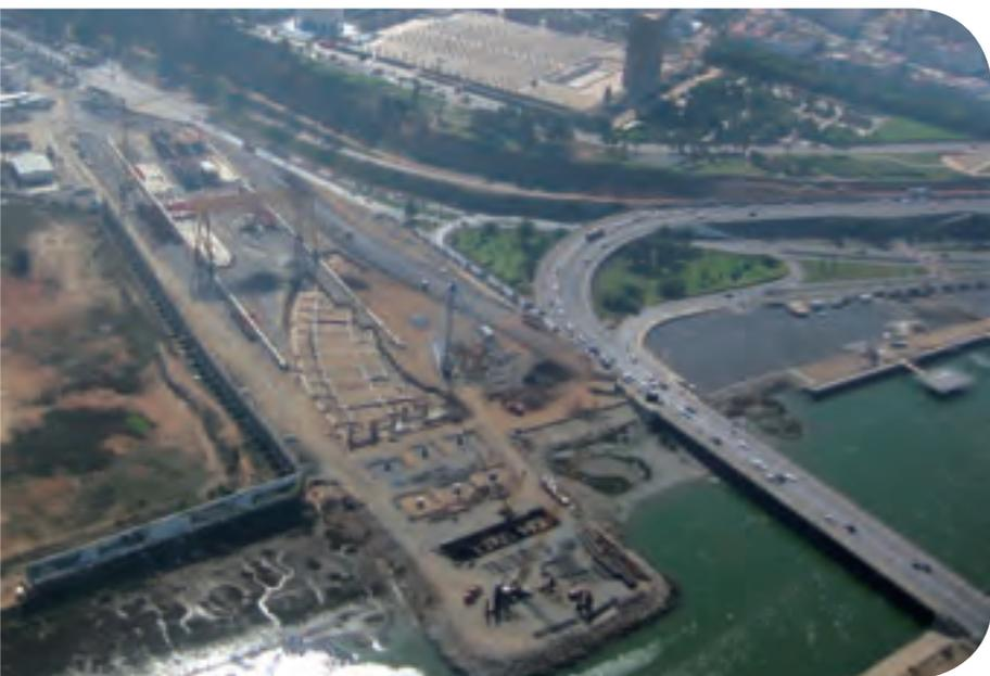
Les éléments préfabriqués du pont Moulay El Hassan sont en cours de fabrication et la pose de l'arc central est prévue en février 2010 dès l'achèvement du pont métallique, ouvrage provisoire spécialement réalisé pour permettre la mise en place des arcs centraux et le passage du portique de manutention de la rive gauche à la rive droite.
