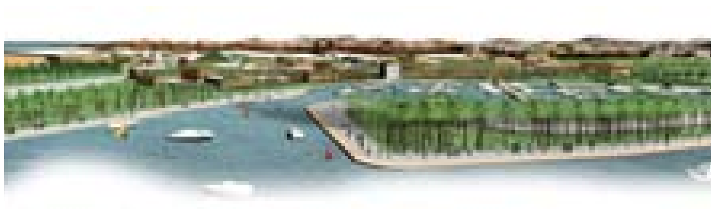
VUE SUR LA MARINA RIVE DROITE
