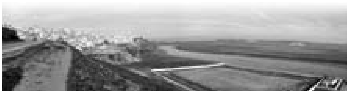
ÉTAT ACTUEL : RIVE DÉGRADÉE PAR LES DÉBLAIS ET LES ÉQUIPEMENTS IMPROPRES
