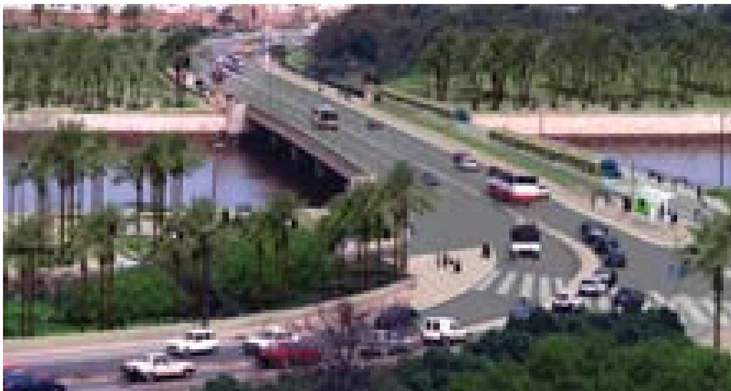
TRAVERSÉE PAR LE TRAMWAY EN AMONT DU PONT MOULAY AL HASSAN
