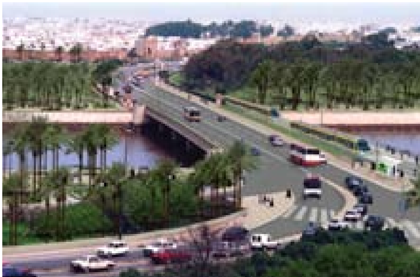
Traversée de la vallée par le tramway, en amont du pont Moulay Hassan
